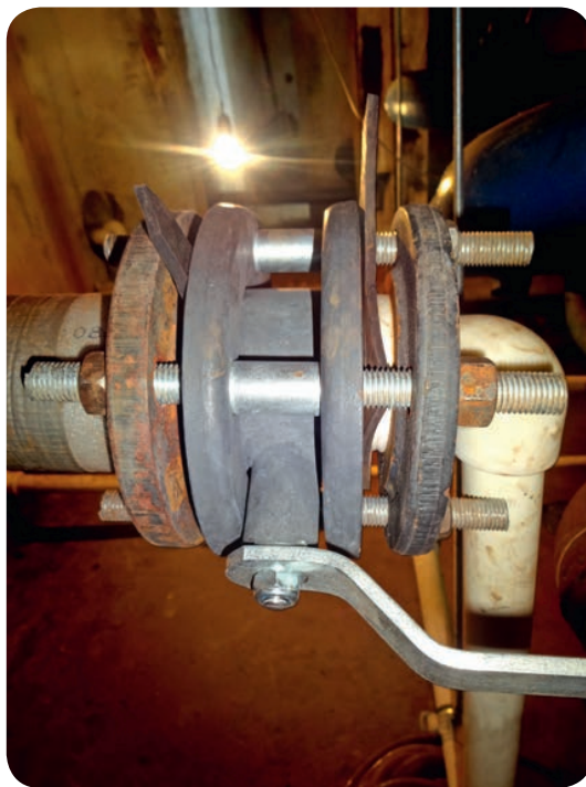
ПОДВАЛ ЖИЛОГО ДОМА (КОНТУР ГВС)
